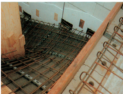
A vasalatot ill. a vasakat megfelelő távolságtartókkal kell lerakni és rögzíteni (42 folyóméter 8 mm-es köracél és kb. 8 m2 vasalat Q131)
