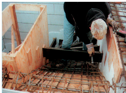
A kihúzható horganyzott lépcsőfokokat 65-ös szögekkel rögzítjük a lépcsőfokhevedereken
