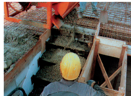
Ezt követően B25-0-16-os szemcséjű betont öntünk 35 - 40 cm-es szétterülési mérettel a lépcsőfokokba
