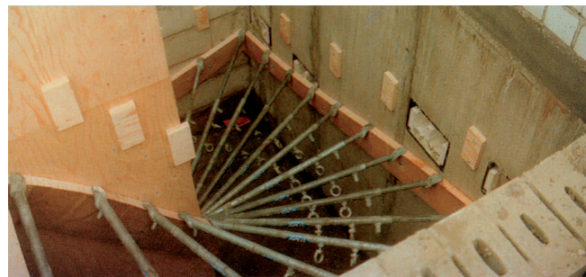
A teleszkópcsöveket az élfához rögzítjük 35 mm-es tetőlemez szeggel kb. 30 cm-es távolságban
