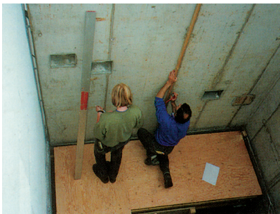
Méretezés irány és méretléccel történik
