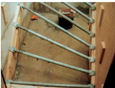
A teleszkópcsövek rögzítése lentől felfelé haladva történik
