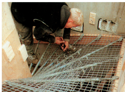
A flexibilis hullámrácsokat a teleszkópcsövekre kell helyezni és a csavaró huzallal rögzíteni
